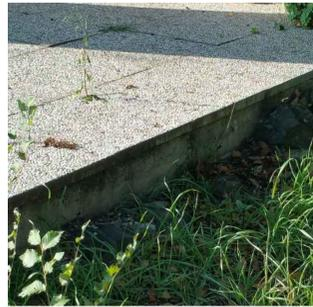
1 dettaglio della piazzetta frontale pavimentata in piastre in cls con effetto ghiaio lavato, sovrapposte al sottofondo in c.a. Sul lato est (rappresentato in foto) è presente un dislivello del piano della piazzetta rispetto la quota del terreno circostante
